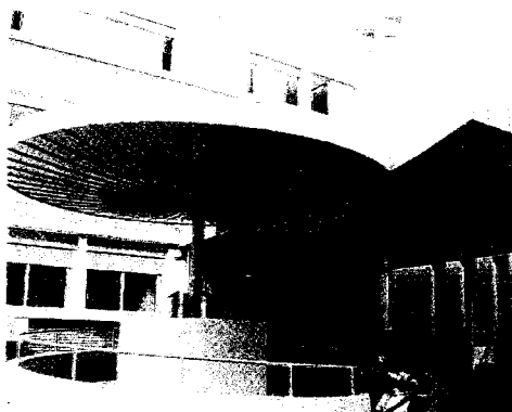
L'ingresso del Liceo Muratori, devastato da un incendio nel 2008
